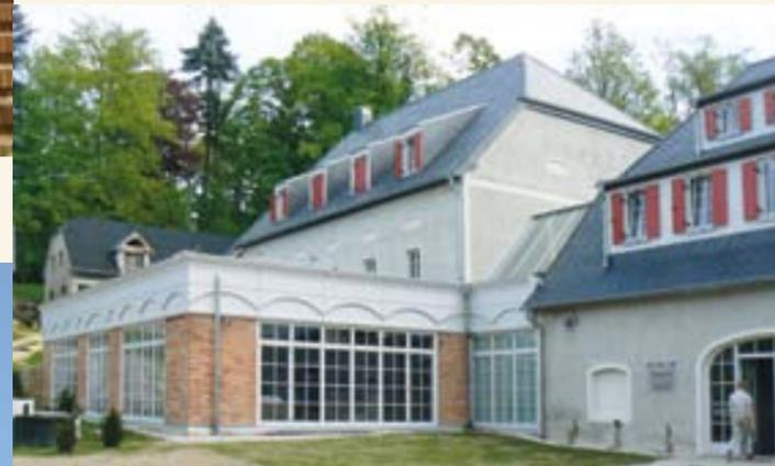
▲ Badehaus am Schloß Stonsdorf unweit von Jelenia Góra (Polen), großflächige Fensteranlagen IV 68 „Meranti sowie Lichtdächer in Holz-Aluminium-Konstruktion“
