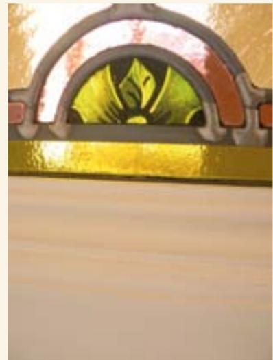
▲ Bemusterung einer Sechsfüllungstür mit Bleiverglasung, Holzart Esche, Lackierung strukturbetont, Fitschenbänder, Drückergarnitur in Messing
