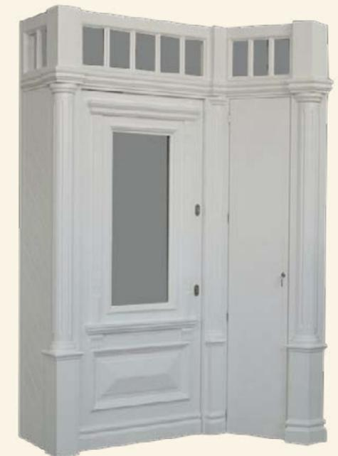
▶ Eingangstür zum Restaurant „Orpheus“ im Stadtzentrum von Brüssel, die schräg angewinkelte schmale Nebentür verkleidet einen E-Schaltschrank, links 90° angeköpelt ein wärmedämmtes Türfutter
