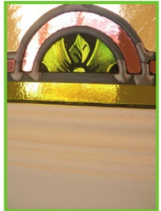
△ Bemusterung einer Sechsfüllungstür mit Bleiverglasung, Holzart Esche, Lackierung strukturbetont, Fischenbänder, Drückergarnitur in Messing
