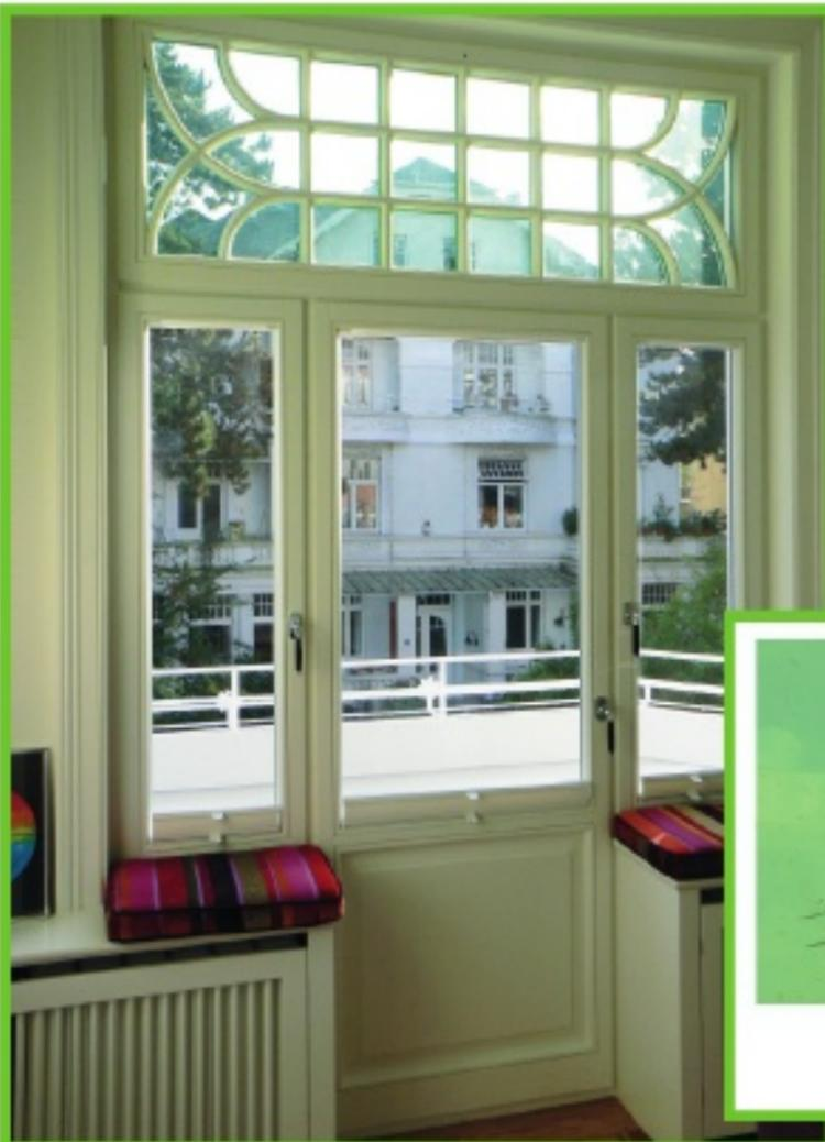
▶ 3-flg. Fenster ohne Pfosten, Oberlicht mit originalem Jugendstil-Sprossenbild und Grünglas sowie mit elektromechanischem Kipp-Antrieb Roto E-Tec-Drive
